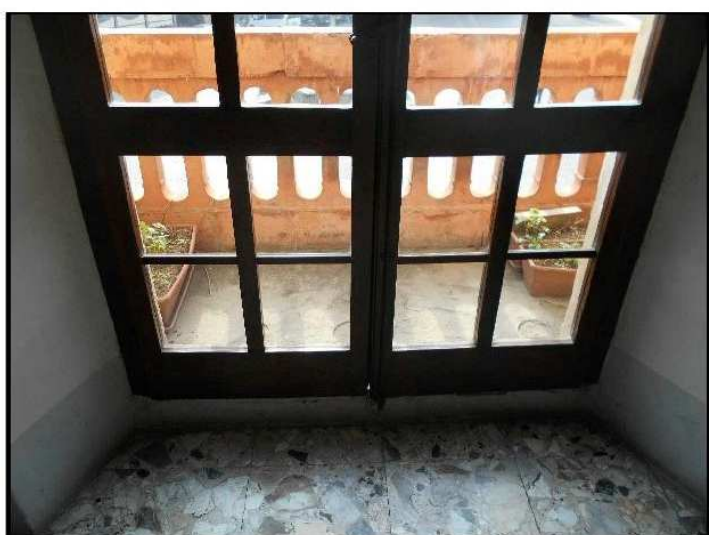
Vista interna n. 6 - portafinestra
